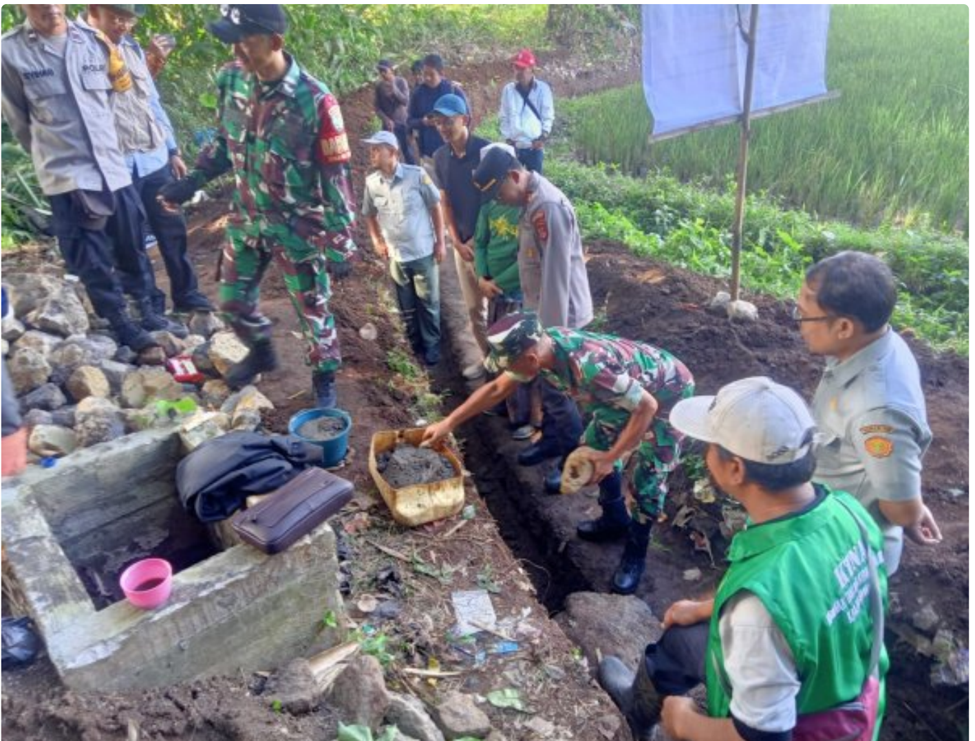
kegiatan peletakan batu pertama Rehabilitasi Irigasi Sawah Tasikmalaya Dimulai
